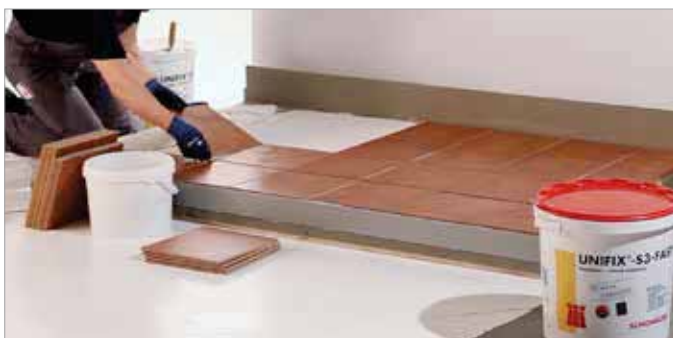
Einschieben der Fliesen in das Fliesenkleberbett, hier im kombinierten Buttering- & Floating-Verfahren.
