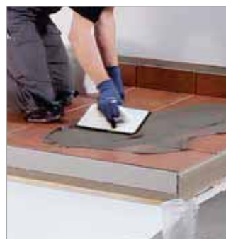
Einfügen des Belages mit ASO®-Flexfuge.
