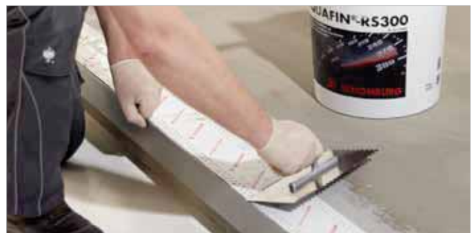
Einarbeitung des Systemdichtbandes ASO®-Dichtband-2000 mit AQUAFIN®-RS300 an das Balkonabschlussprofil.
