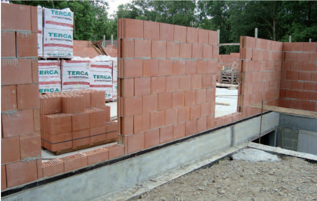
Mauerfußdämmung mit FOAMGLAS® PERINSUL unter Hochlochziegeln.
