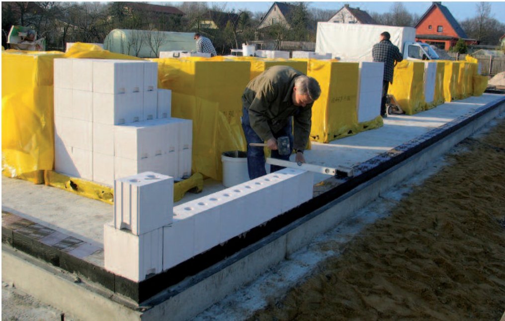
Mauerfußdämmung mit FOAMGLAS® PERINSUL unter Kalksandsteinen.
